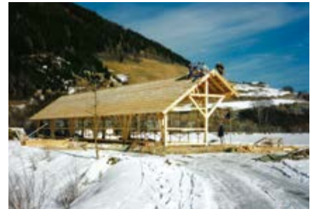
Die Abschlagshütte wird errichtet
